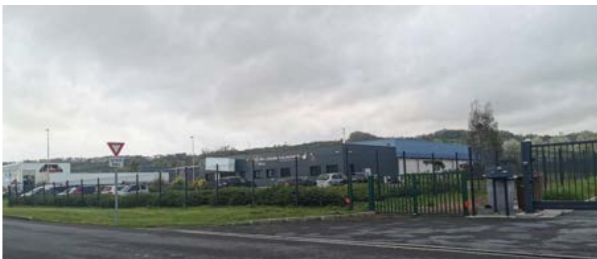
Zone d'activités, avenue François Mitterrand, Dives-sur-Mer, avril 2024.
