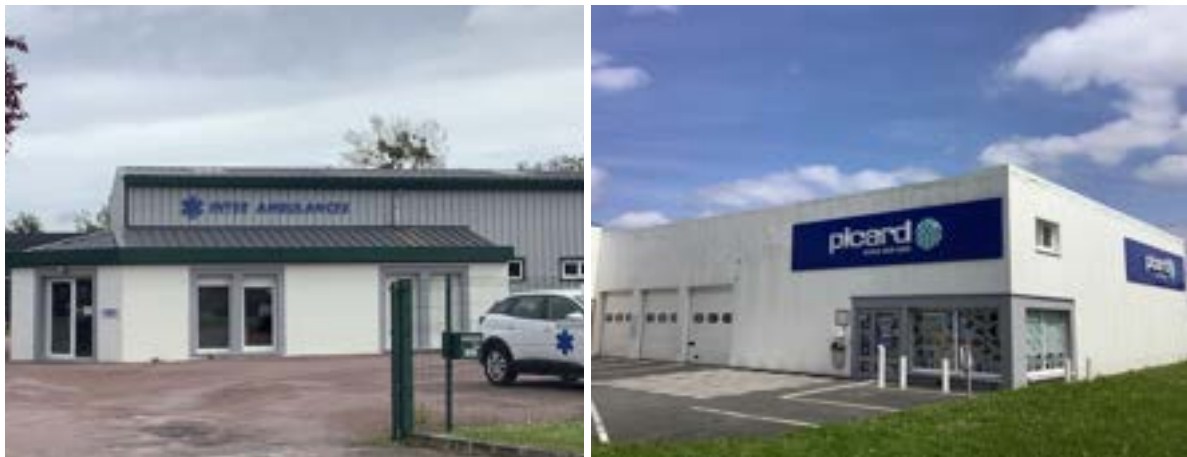
Enseignes réalisées en lettres ou signes (avec ou sans panneaux de fond) en zone d'activités, Dives-sur-Mer, avril 2024.
