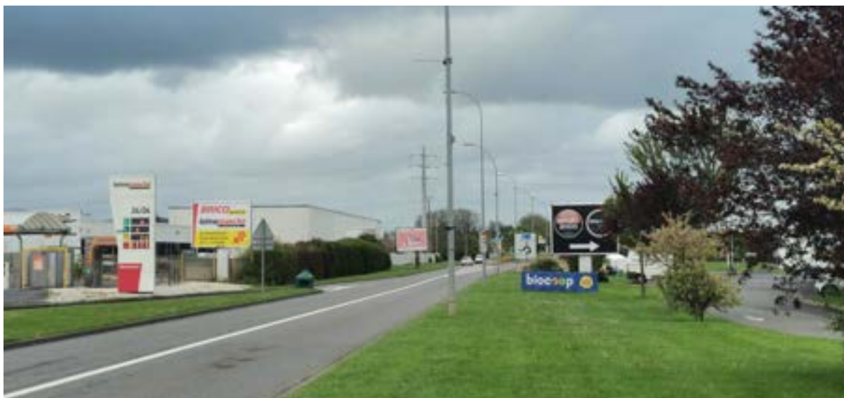
Entrée de la zone d'activités sud de la commune, boulevard Maurice Thorez, Dives-sur-Mer, avril 2024.
